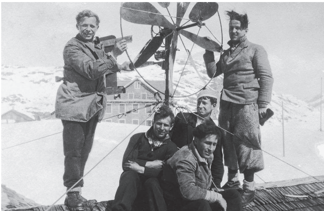
Für das «Post-Huisli» auf der Frutt erschuf Christian Sigrist eine der ersten «Alternativenergie-Anlagen» zur Stromgewinnung. Sie funktionierte perfekt, hielt aber dem Wintersturm nur eine Woche stand.
